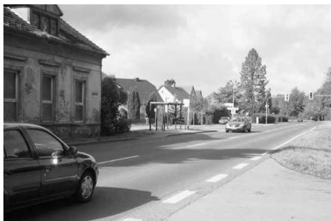
Die Ortsdurchfahrt wird 2012 erneuert.
